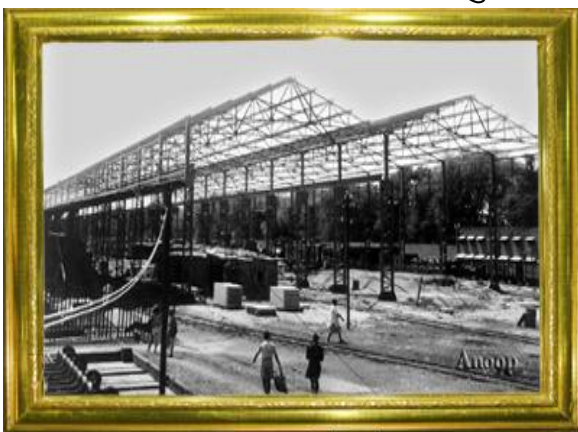
आरा कल शाप का निर्माण कार्य
